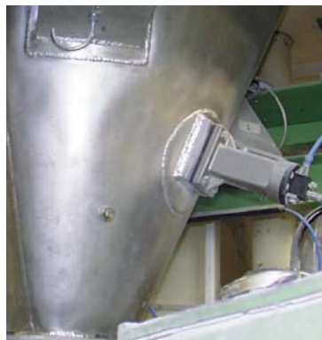
Abreinigen von Bunkerwänden
